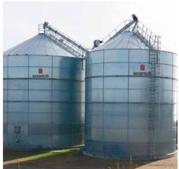
1238/8 à 1287 m 3 og 930/8 à 706 m 3 . 40 tons transport med kæde-elevator til tagkant samt 2 kæde-elevatore langs tagstige.
