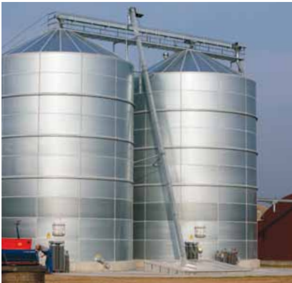
To stk. 930/10, totalt 1732 m 3 . 40 tons transport med grav, kæde-elevator samt gangbro med reversibel redler.
