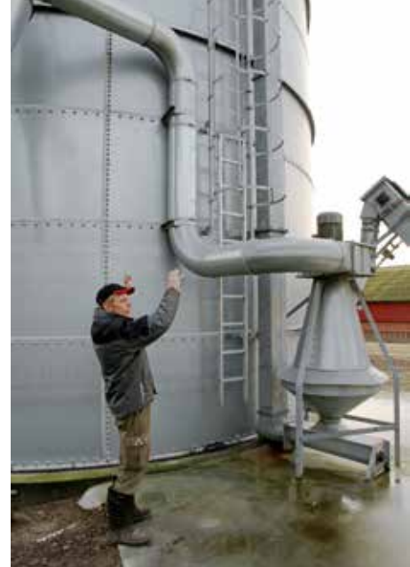
Thorkild Frederiksenin siilo on varustettu esipuhdistajalla.
