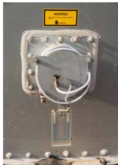
Siiloissa on nestetoiminen painemittari sekä liitäntä hiilidioksidin lisäämiseen.
