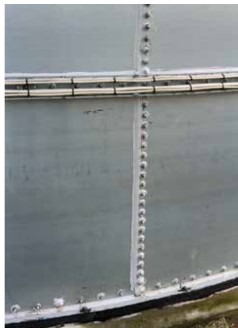
Siilojen kaikissa saumoissa käytetään tiivistemassaa.
