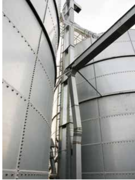
Samaa tasokuljetinta käytetään sekä siilojen täyttöön kaatosuppilosta että siilojen tyhjennykseen rehustamoon.
