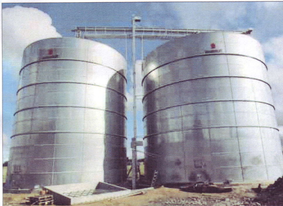
Der er især diameteren til forskel på siloerne. Til højre siloen til hvede på 2.956 m 3 med en diameter på 15,48 m. Siloen til byg er på 1.855 m 3 og har en diameter på 12,38 m. Foto: Jensen Tønnesen.
